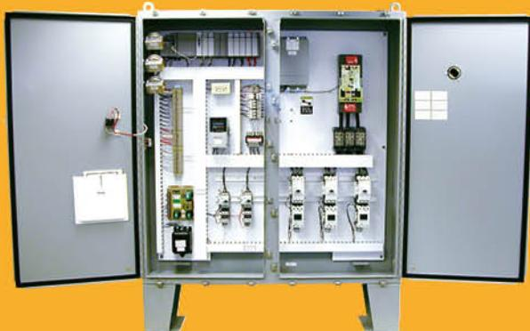
Блок питания сушилки, показанный выше, установлен в большой корпус NEMA IV, все компоненты электрического питания и мониторинга сушилки управляются контроллером SCL производства Allen Bradley. Электрическая схема и электропроводка сертифицирована лабораториями MET, поэтому данная система удовлетворяет всем стандартам безопасности США и Канады. Это гарантирует долговечность и надежность системы управления сушилкой.
