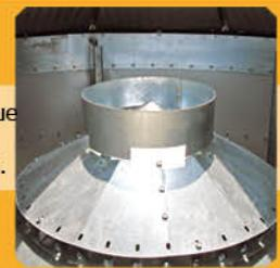
**2** Самоочищающееся демпфирующее устройство на крыше накопительного бункера уменьшает повреждения, наносимые зерну при загрузке, и износ крыши бункера.
