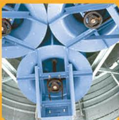
**14** Установленные внутри цилиндрические радиальные нагнетатели доставляют воздушный поток в секцию нагрева, находящуюся под давлением, и в вытяжную секцию охлаждения.
